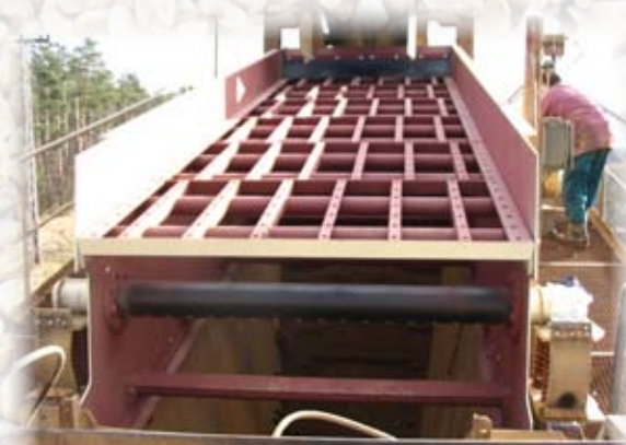
MONTÁŽ NOVÝCH RÁMŮ ■ Štěrkopísek ■ 2006
